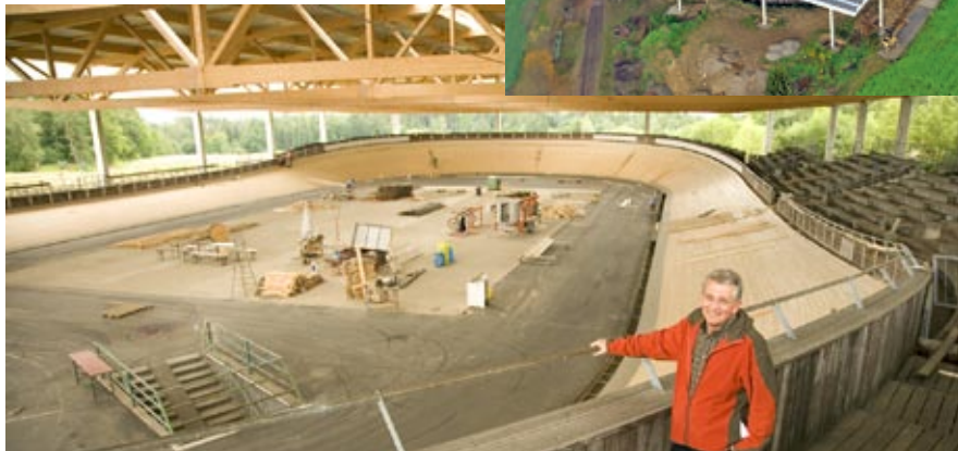
Reiner Dinger, der Gründer des Radsport-Fördervereins Gäufelden, vor „seinem Baby“, der neuen, überdachten Radrennbahn mit der Solaranlage auf dem Dach.
